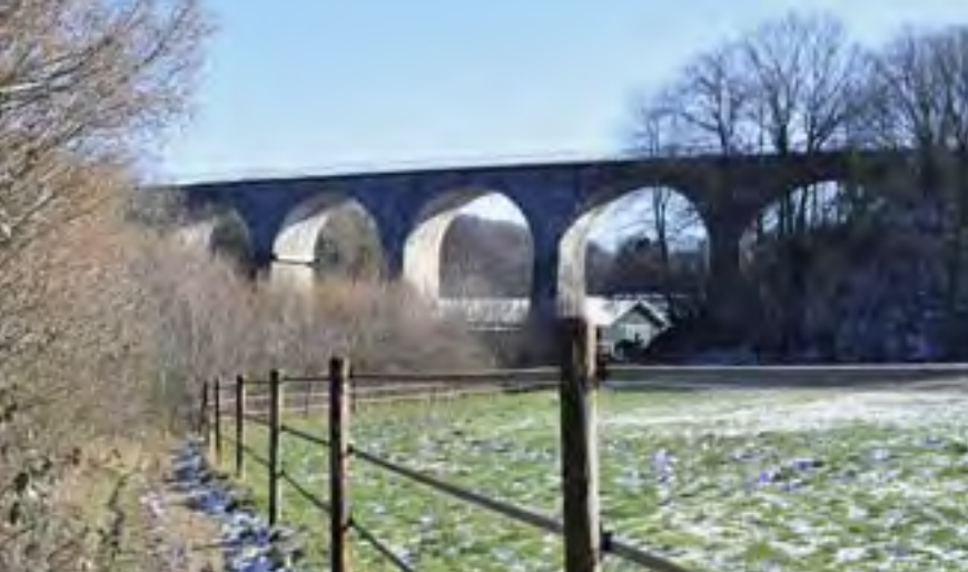
Das Vennbahnviadukt im Winter
